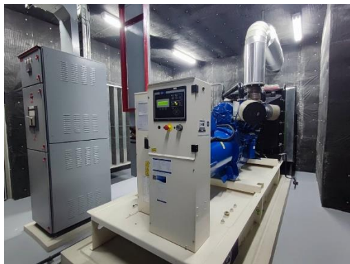
รูปที่ 43 เครื่องสำรองไฟ
