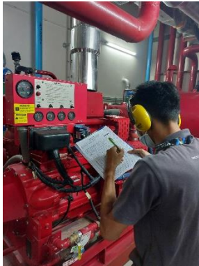
รูปที่ 17 เจ้าหน้าที่ตรวจเช็คเครื่องปั้มน้ำสำหรับดับเพลิง
